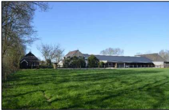
Afbeelding 1.1. Woning en manege vanaf het zuiden
