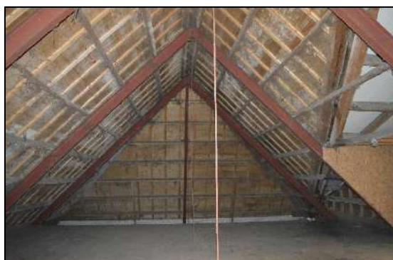
Afbeelding 2.15. Binnenzijde zolder van schuur.
