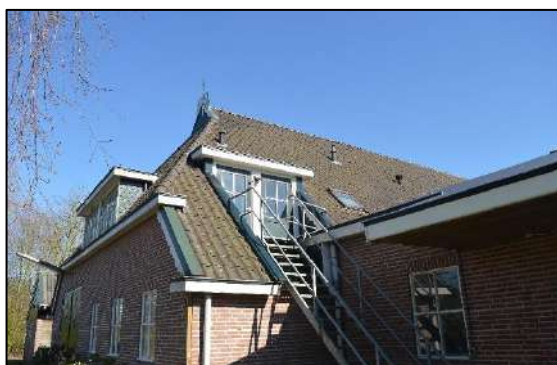
Afbeelding 2.6. Schuur met toegang tot appartement.
