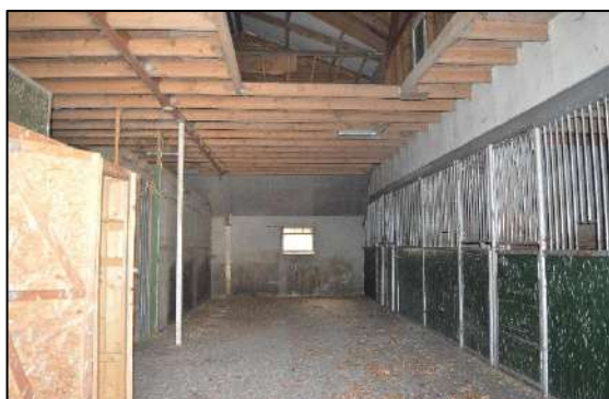
Afbeelding 2.14. Binnenzijde schuur met stallen.
