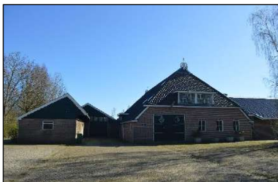
Afbeelding 2.4. Schuur met stallen vanaf noorden.
