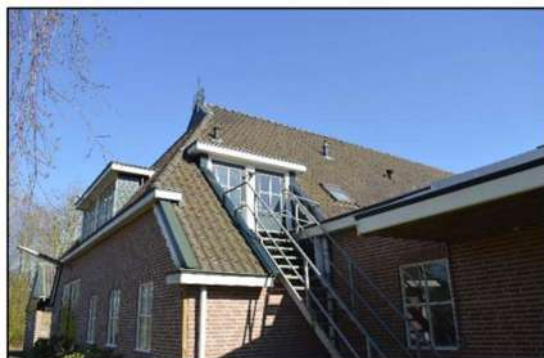
Afbeelding 1.5. Schuur met toegang tot appartement.
