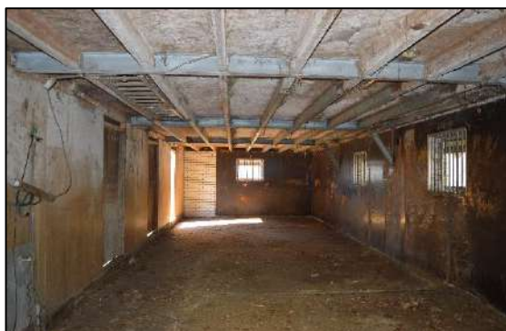
Afbeelding 2.12. Binnenzijde stallen aan oostzijde.
