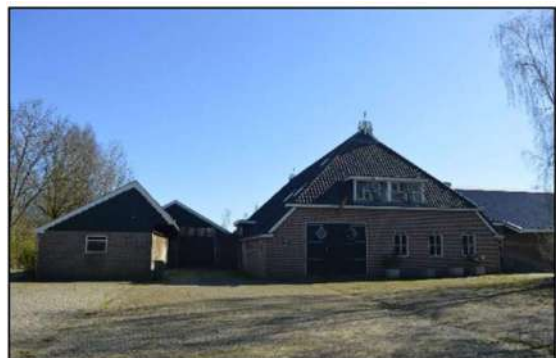
Afbeelding 1.4. Schuur met stallen vanaf het noorden
